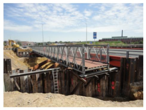
Dans le prolongement des deux ponts RHB, Retro Bridge a livré et installé deux ponts RLB (Retro Light Bridge) qui enjambent l'autoroute N2. Dotés de notre système lourd de parapet sur un côté, les deux ponts ont été construits de façon décalée dans le sens de la longueur parallèlement entre eux pour aménager un croisement d'une largeur de
