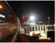
Les ponts provisoires ont été installés à l'aide d'une grue par des équipes qui ont travaillé la nuit pour limiter au maximum les perturbations du réseau local. Tous les travaux ont été réalisés sans heurt à la plus grande satisfaction du client.
