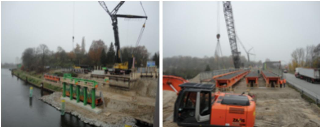
Les éléments RHB ont été installés à l'aide de deux grues télescopiques de 800 tonnes positionnées sur les berges de part et d'autre du canal. Les éléments de 61 tonnes et 40,5 mètres ont été soulevés en tandem et mis en place par les grues. Une fois en place, le boulonnage des raccords longitudinaux entre les éléments de pont s'est déroulé rapidement et sans heurt.
